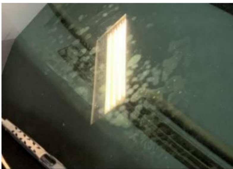
图 3.7.1 玻璃表面均匀白雾状
